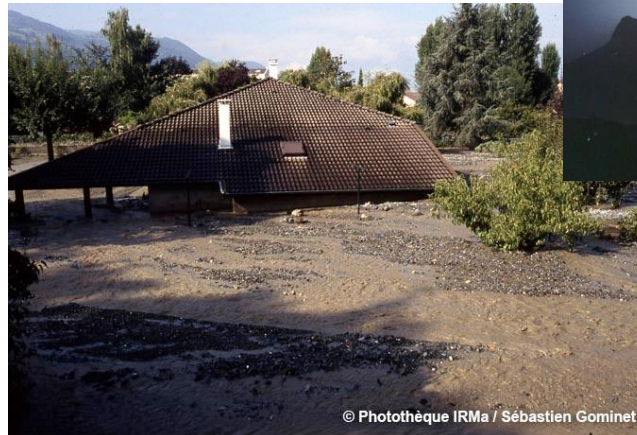
Crue torrentielle du Doménon, 2005
